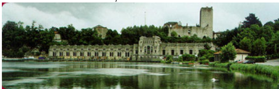
Trezzo sull'Adda: fluente (10 MW; 56 GWh)
